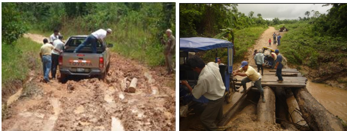
Foto N° 3: ámbito de intervención con serias limitaciones de acceso. Foto N°4: Puente artesanal que fue reemplazado (apoyo de DEVIDA)
