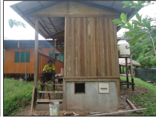
Foto N° 54: Instalaciones de uso múltiple en las viviendas
